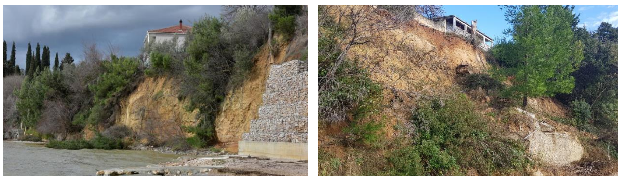
Slika 3.1 Strme litice duž obale mora u Posedarju, izložene trošenju stijena kvartarne starosti i eroziji morskim valovima. Kao posljedica prirodnih predispozicija, u kombinaciji s nepovoljnim djelovanjem površinskih voda, osim odrona, na ovakvim liticama nastaju i klizišta.
