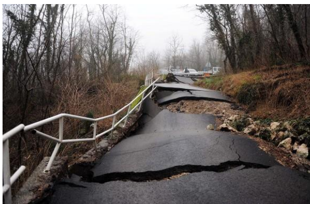
Slika 3.5. Štete na prometnici koje je izazvalo klizište Valiči aktivirano u veljači 2014. godine u Općini Jelenje.
