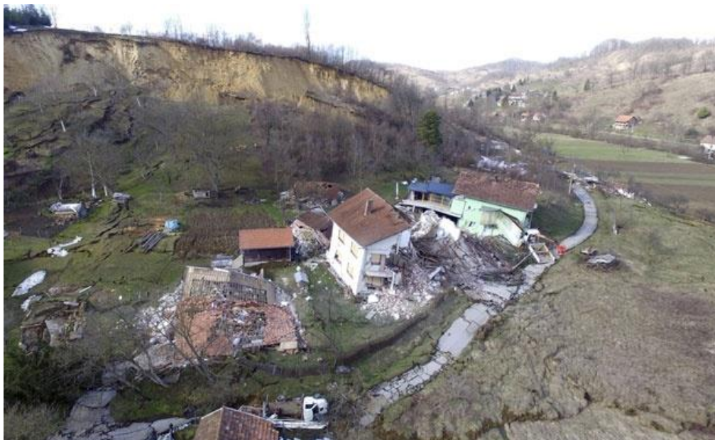
Slika 3.8. Štete na srednje velikom klizištu u Hrvatskoj Kostajnici aktiviranom u ožujku 2018. godine kao posljedica ekstremnih oborina.
