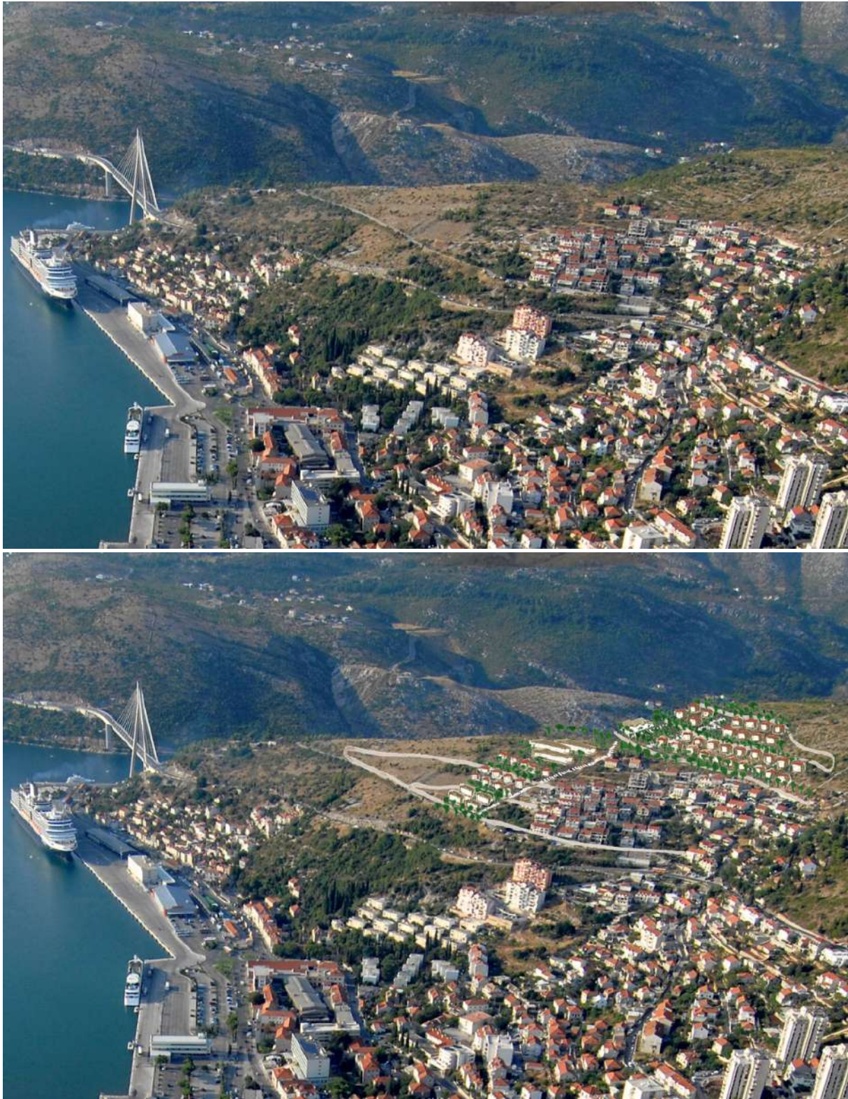
Grafički prikaz 4: Usporedni prikaz postojećeg stanja i planirane gradnje unutar obuhvata UPU-a prema Prijedlogu UPU-a iz travnja 2016. godine
