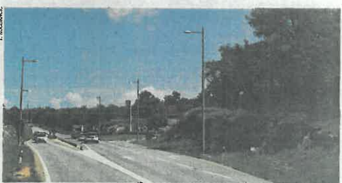
Opasna dionica zaobilaznice kod Petrola
