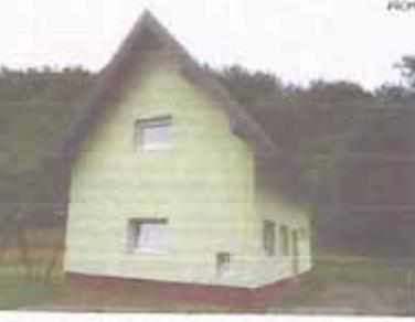
U sklopu energetske obnove izvedeni su ugovorni poslovi i izvojni radovi: izgradnja nove drvene konstrukcije krovova i novi pokrivači od gline i crepova. Nadalje, izvedeni su izolacijski radovi u vidu postavljanja toplinske izolacije krovova i vanjske ovojnice zgrade. Izvedeni su i električni radovi kao i radovi na elektroinstalacijama odnosno prostornostrukturnim instalacijama. Zamijenjena je stara drvena stolarija novom PVC stolarijom po principu RAL ugradbe.
