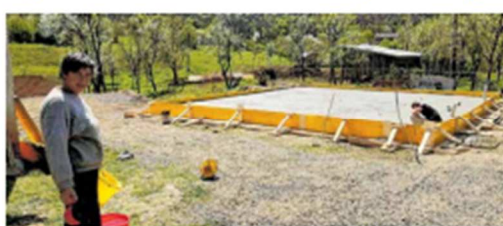
Postavljen temelj nove kućeb trebala biti izgrađena do kraja svitjega
