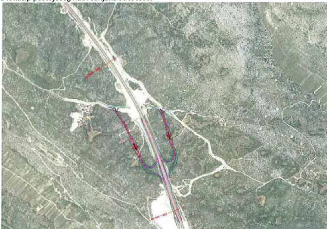
V2 - na lokaciji postojećeg nadvožnjaka autoceste
