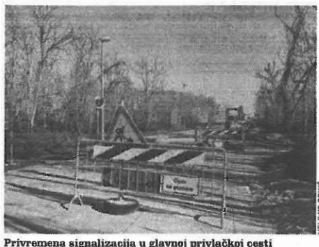
Privremena signalizacija u glavnoj privlačkoj cesti
