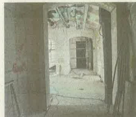
Postavljaju se instalacije
