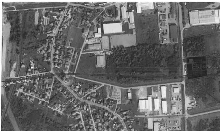
Slika 1. Zajednička dionica VN dalekovoda DV 110 kV Žerjavinec – Dugo Selo i DV 110 kV Resnik – Dugo Selo (4 stupna mjesta)
