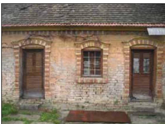
Kuća s okućnicom, Jurišićeva ulica 38
