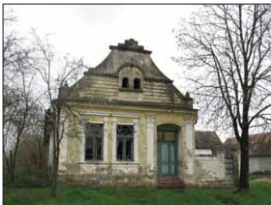
Kuća u ulici V. Nazora 19
