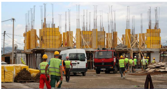
Građevinski radovi, kamp Konik, Crna Gora
