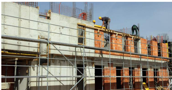
Građevinski radovi, Glina, Hrvatska
