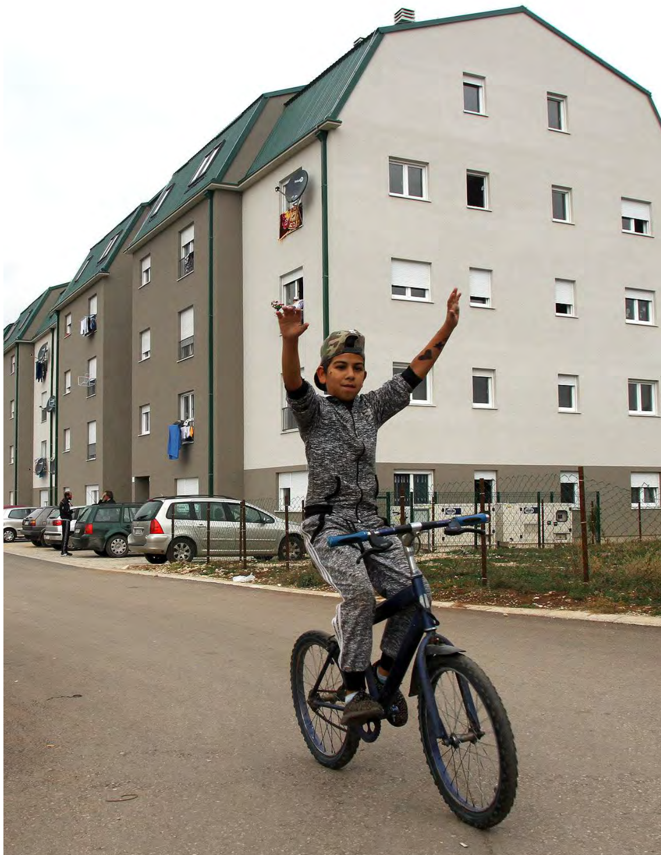
Završena zgrada u Nikšiću, lipanj 2016.
