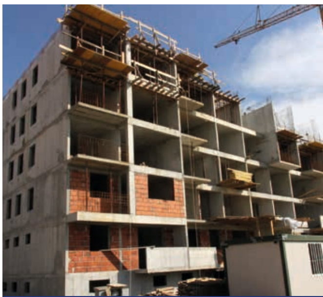
Radovi na izgradnji zgrade u Prijedoru, svibanj 2017.
