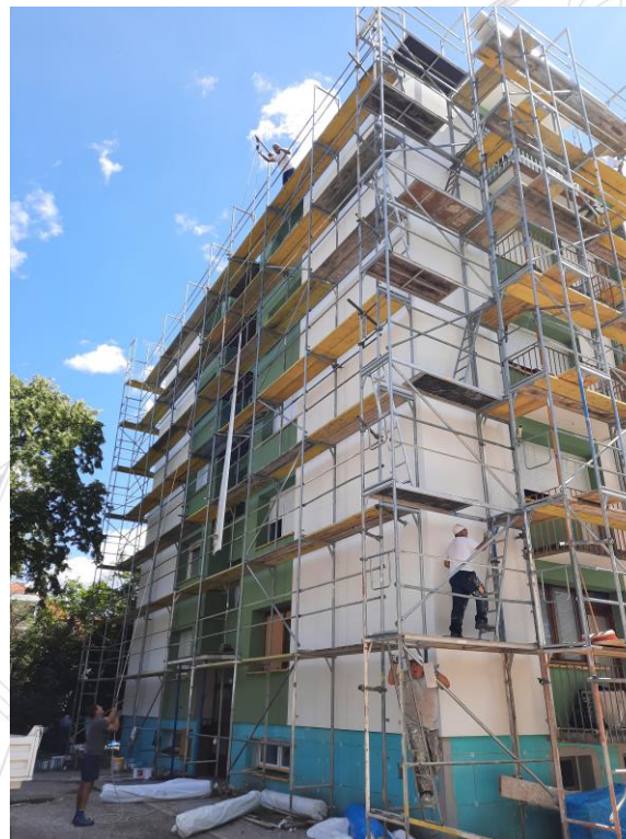
tijekom izvođenja radova
