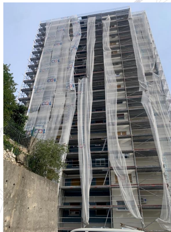
tijekom izvođenja radova
