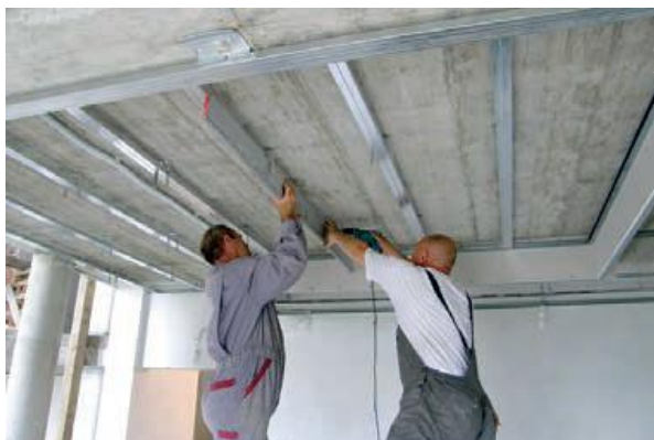
Potkonstrukcija s direktnim pričvršćenjem 87
