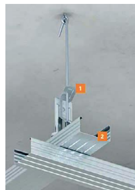
Potkonstrukcija u jednoj razini 88
