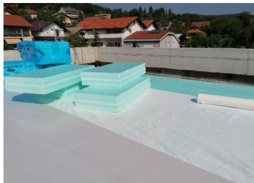
Toplinska izolacija ravnog krova 78
