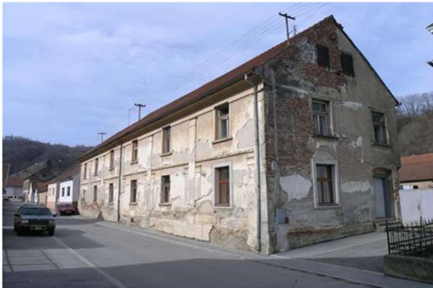
Požega, Zgrada Prve gradske bolnice, Vučjak 34 (autor fotografije: M. Bender Maringer)
