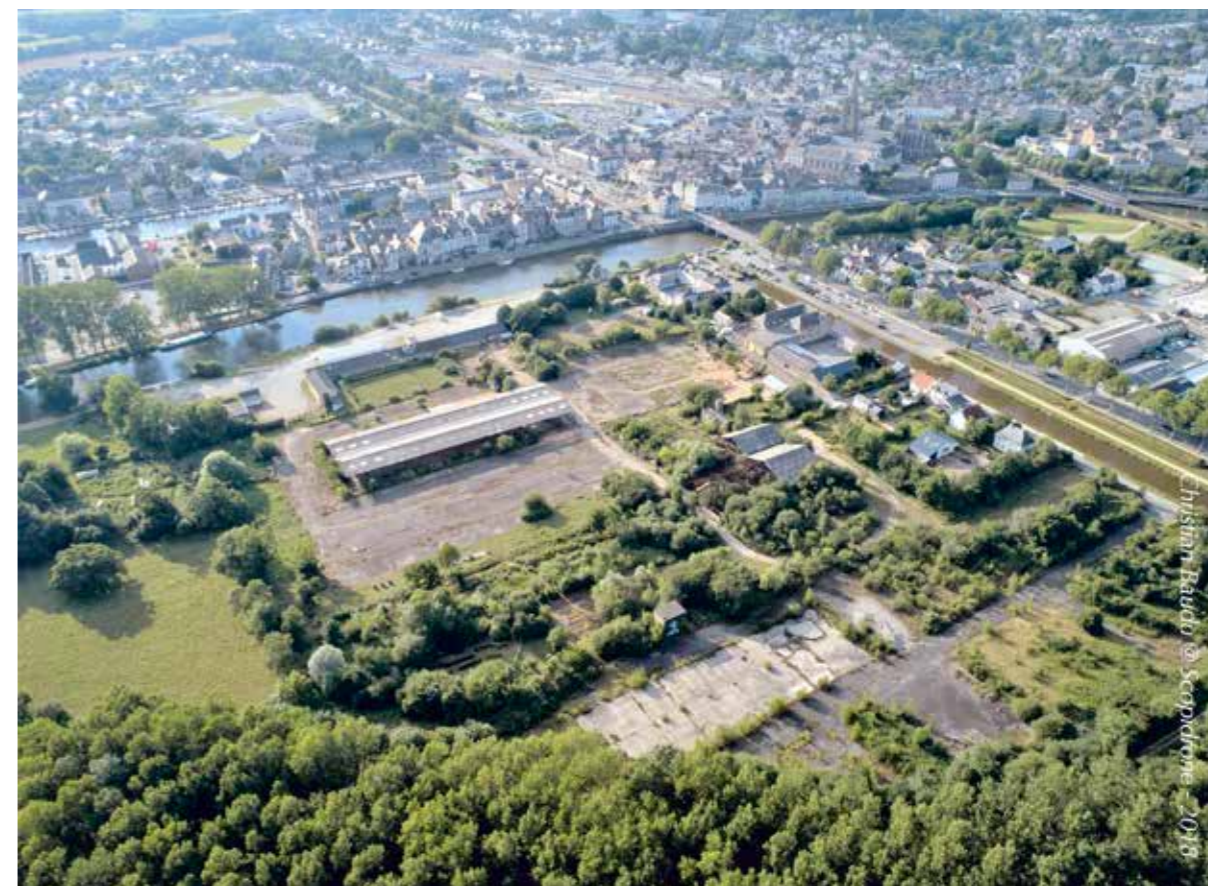
Le Transformateur u Općini Saint Nicolas de Redon predstavlja niskobudžetni projekt za urbanu obnovu brownfield područja koji provode lokalni stanovnici. ©Christian Baudu – Scopidrone
