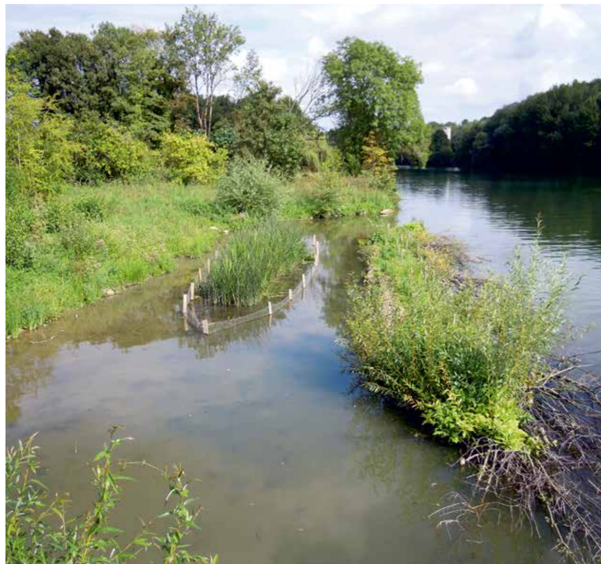
Tehnike ekološkog inženjerstva koriste se za obnovu riječnih obala kako bi ih se zaštitilo od erozije, stabiliziralo i kako bi se omogućila njihova regeneracija. ©Gilles Lecuir
