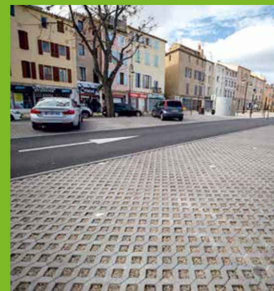
Propusni kolnici ili porozni asfalt, koji su uistinu korisni na određenim površinama radi poboljšanja upravljanja oborinskim vodama, nisu primjeri urbane obnove. ©Gilles Lecuir (lijevo) ©Commune de Narbonne (desno)
