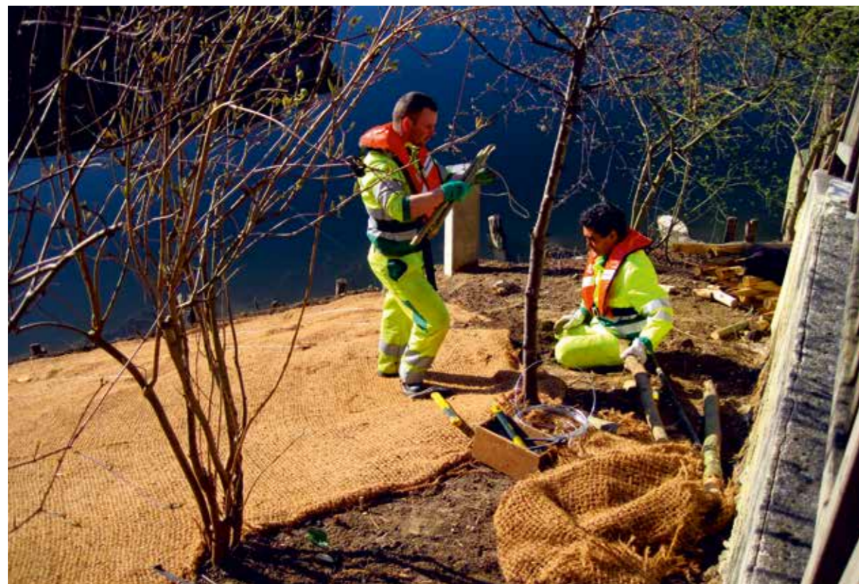
Tkanje s vrbama udruge Espaces na otoku Île Saint-Germain u Općini Issy-les-Moulineaux radi stabilizacije i pokrivanja riječne obale vegetacijom. ©Udruga Espaces
