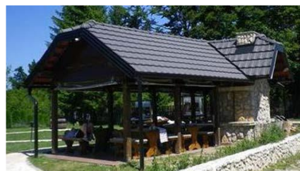
otvoreno ognjište izgrađeno bez ishođenog odobrenja za gradnju
