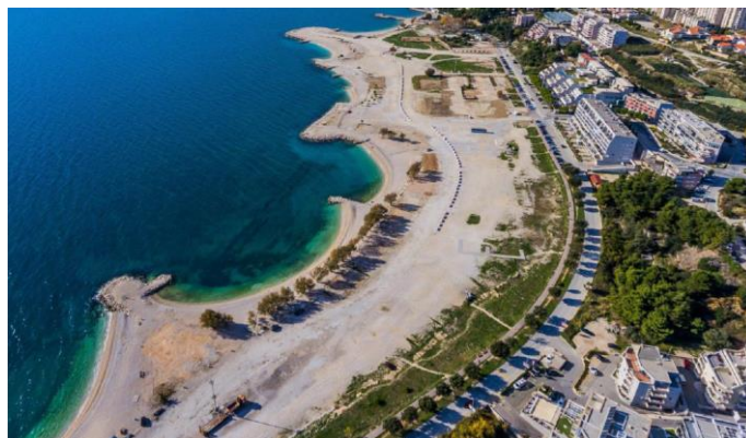
Žnjan – stanje nakon postupanja inspekcije
