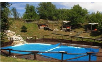
izgrađen PVC bazen pri dnu vrtače s vidljivim instalacijama, drvena staza, te zaštitna ograda sve bez ishođenog odobrenja za gradnju
