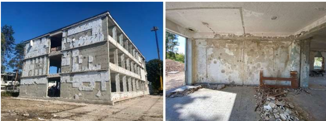
Slika 2. Zgrada koju je potrebno rekonstruirati u sklopu ovog Projekta (Zajma 9127HR)
