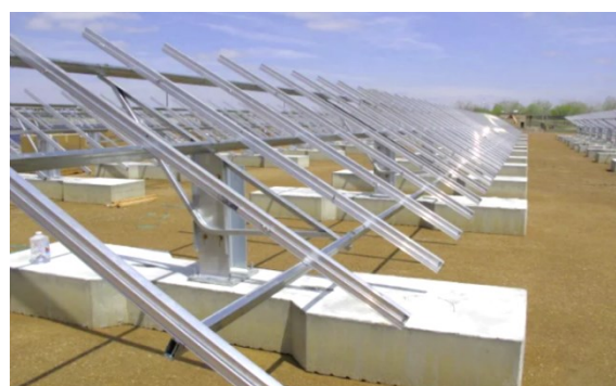
b) postavljanje na betonske blokove
