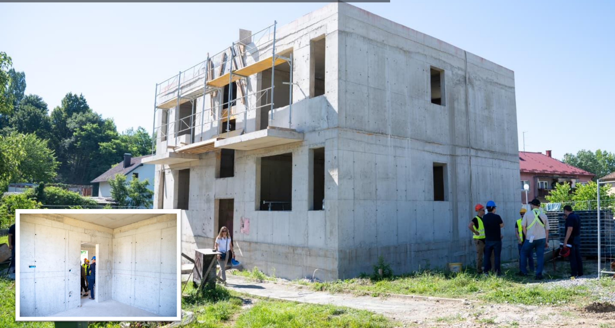
Novska - obilazak gradilišta izgradnje zamjenske višestambene zgrade
